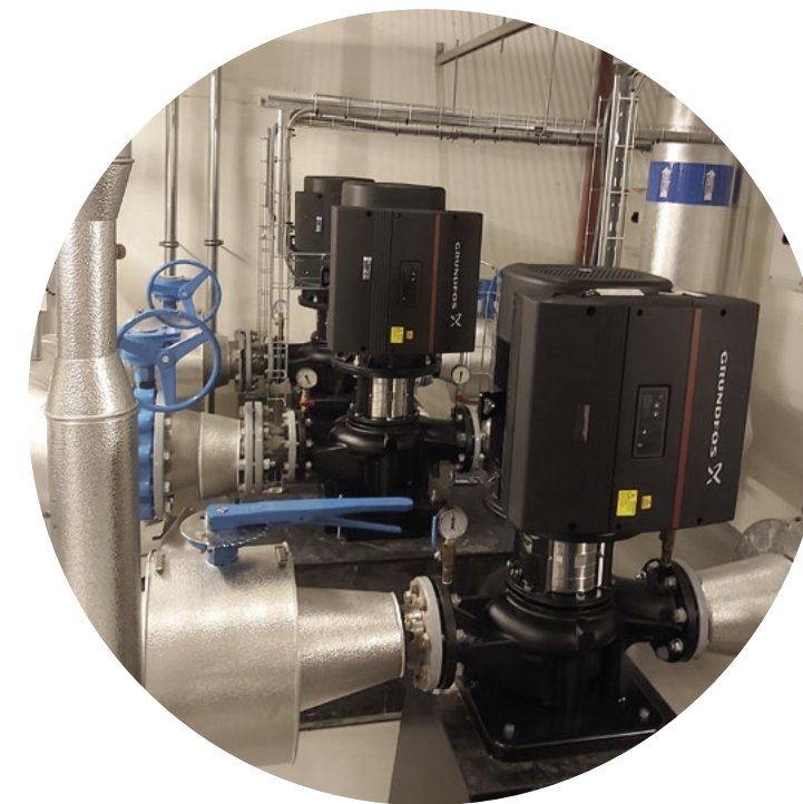
Bildet viser nye effektive pumper på St. Olavs hospital – Akutt, hjerte og lungesenteret
